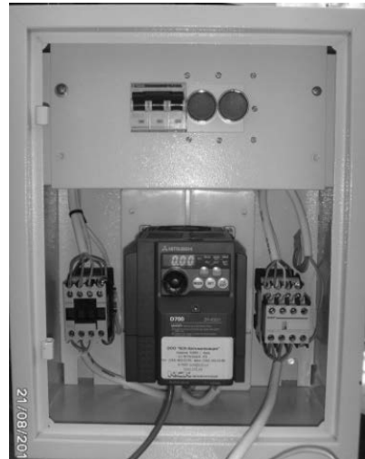
Рис. 8. Частотний перетворювач Mitsubishi FR-D740 для керування рухом скребкового конвеєра.
