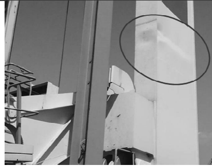
б) деформация внешней стенки и верхней полки морской консоли
