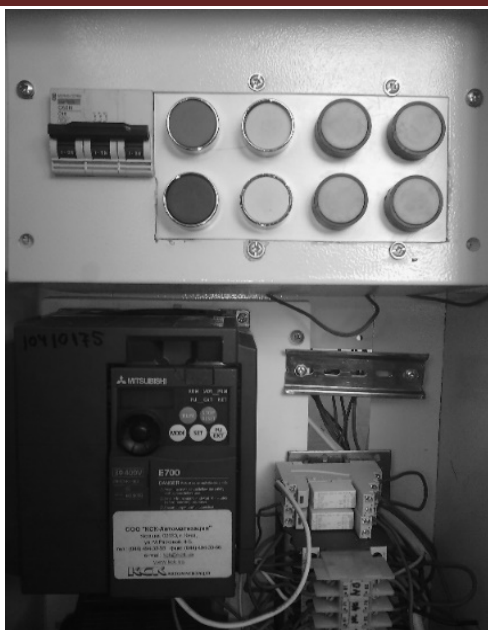
Рисунок 5 – Електрошафа з частотним перетворювачем Mitsubishi FR-E740-060
