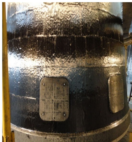
Рисунок 6 – Выкладка слоев внутренней обшивки МСО
