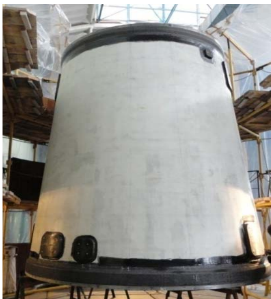
Рисунок 5 – Установка на оправку шпангоутов и окантовок люков
