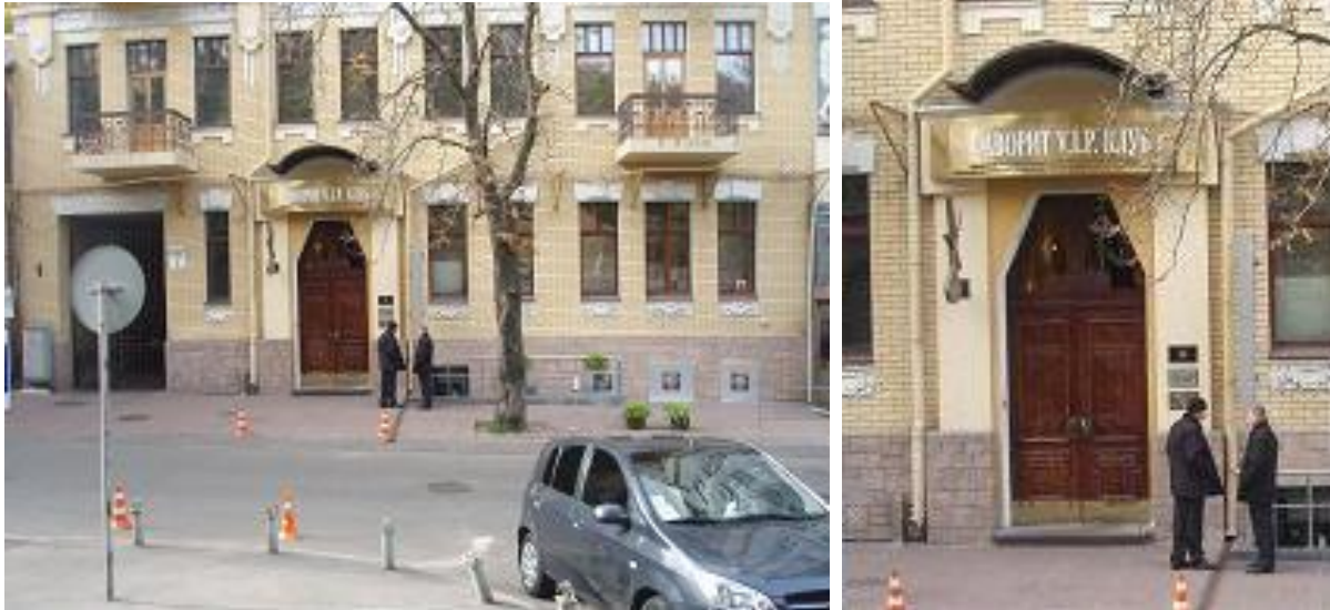
Рис. 7. Будівля по Музейному провулку, 6
