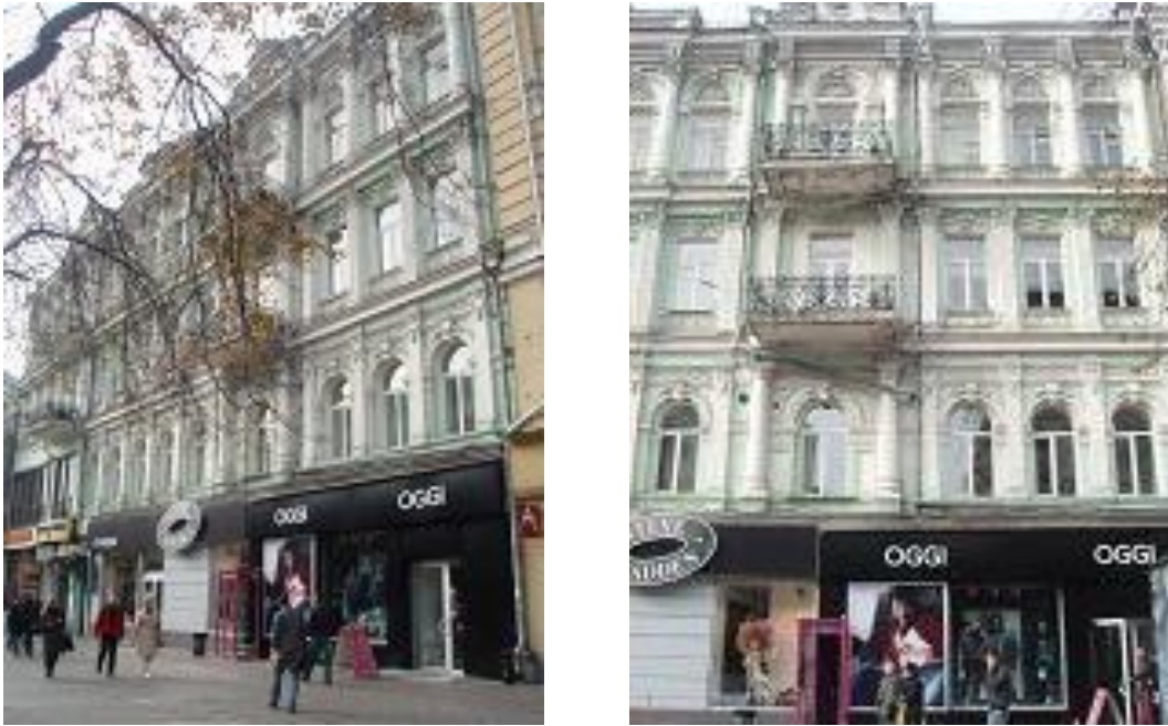
Рис. 5. Будівля по вулиці Хрещатик, 44
