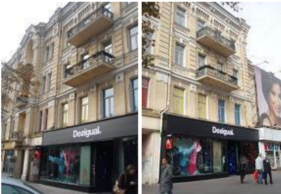
Рис. 4. Будівля по вулиці Хрещатик, 42
