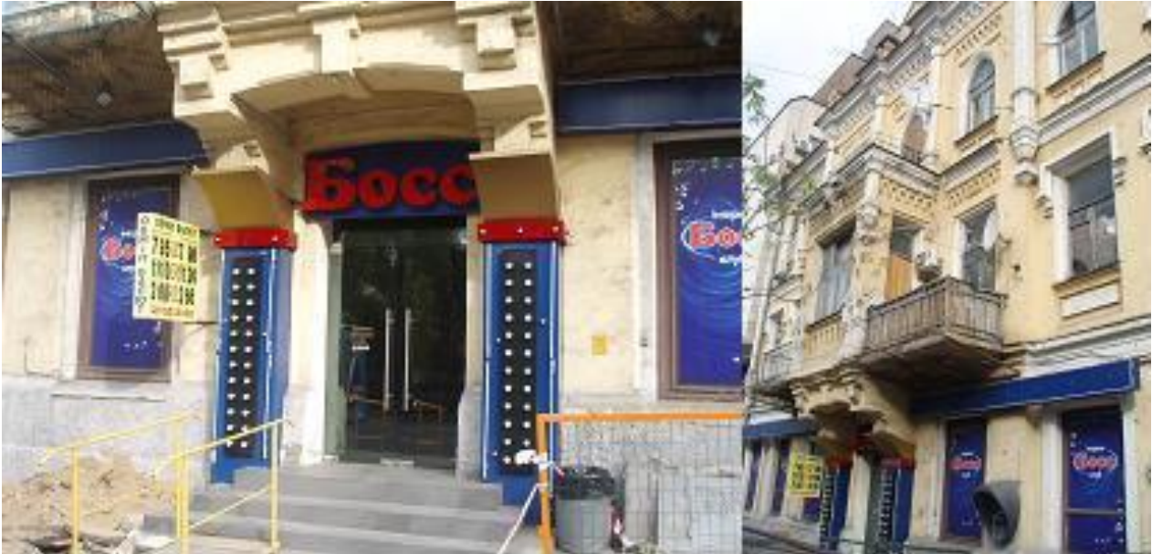
Рис. 1. Будівля по бульвару Тараса Шевченка, 36.
