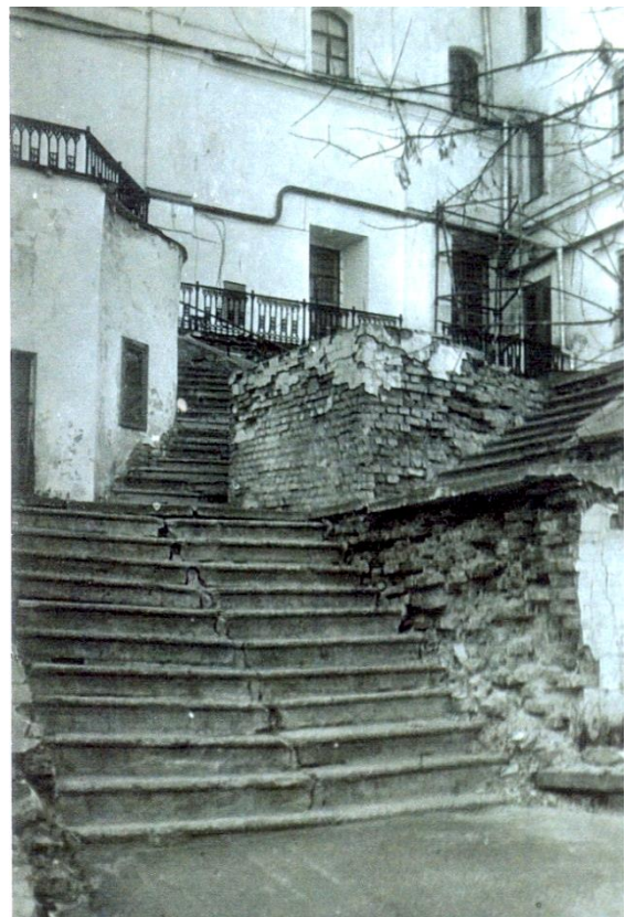
Рис.2. Поруйновані зсувом сходи з тильного боку корпусу друкарні.
