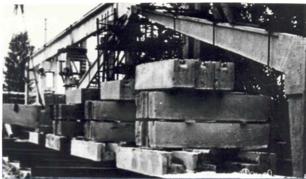
Рис. 1. Випробування рами завантаженням штучними вантажами
