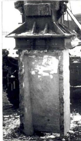
Рис.10. Палі із вертикальних елементів, об'єднаних діафрагмами СВД
