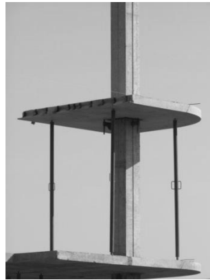
Рис. 1 – Житлова 16-ти поверхова будівля безкапітельно-безригельної конструктивної системи в процесі зведення (а), спирання надколонної плити на колону (б)
