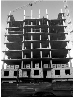
Рис. 1 – Житлова 16-ти поверхова будівля безкапітельно-безригельної конструктивної системи в процесі зведення (а), спирання надколонної плити на колону (б)
