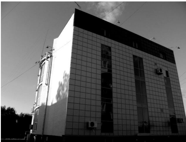
Рис. 1. Фото – Промислова будівля.
