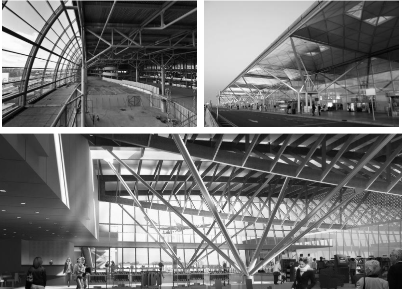
рис. 1. Конструкції одноповерхових великопролітних будівель і споруд аеропортів
