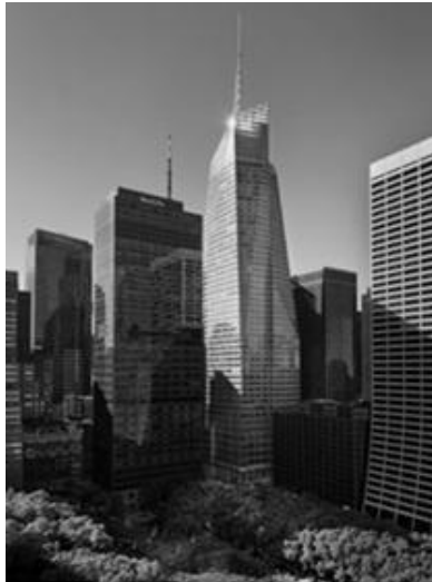
Рис. 5 Bank of America Tower. Споруда з офісними приміщеннями, Нью-Йорк, США
