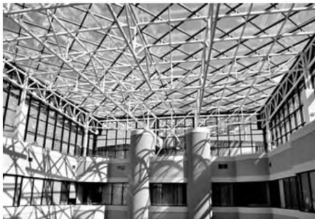
Рис. 7. Композиційний центр будівлі Солом'янської РДА – просторий атриум з прозорим дахом
