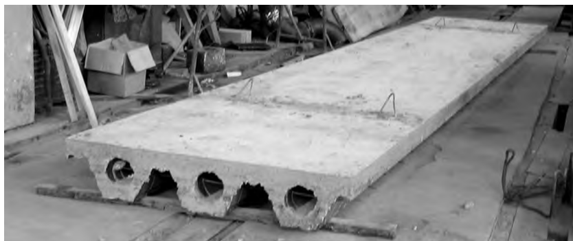
Рис. 2. Конструкція багатопорожнистої ребристої плити з зовнішнім армуванням профнастилом ТП 128, розміром 6,0х1,0 м
