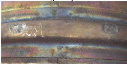
Рис. 5. Жаровая труба со следами износа
