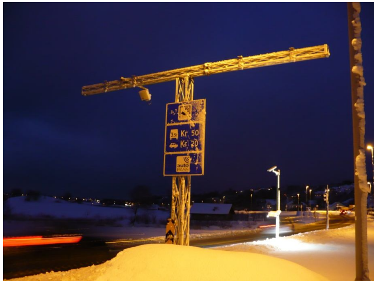
Rys. 1. Przykład punktu kontrolnego systemu opartego na technologii DSRC w Stavanger
