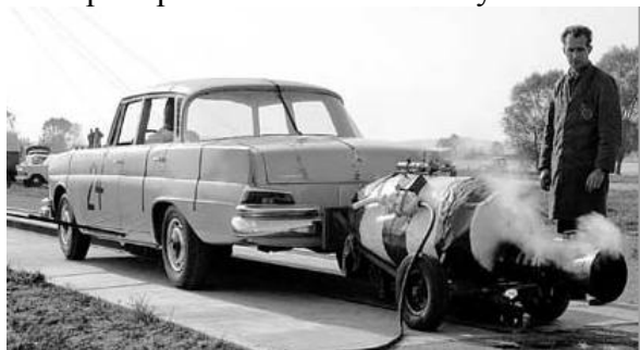
Барені при проведенні краш-тесту експериментального автомобіля
