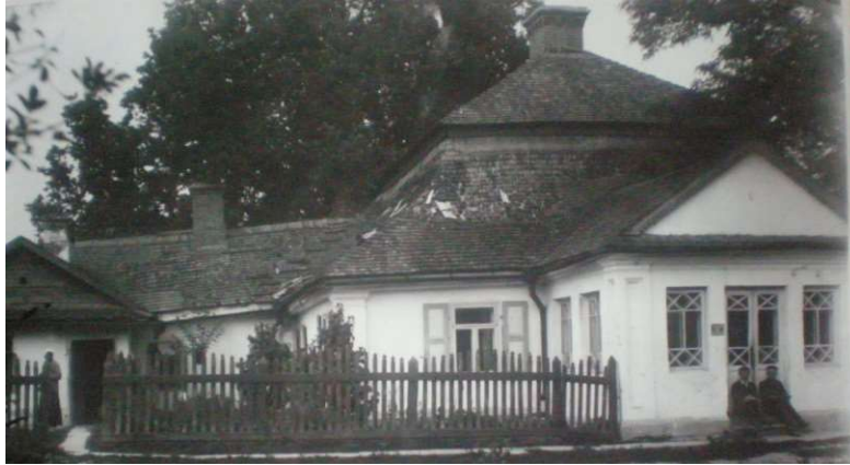
Рис.1. Дерев'яна садиба по вул. Ярошука, 9 (Фонд ЛДКЗ)
