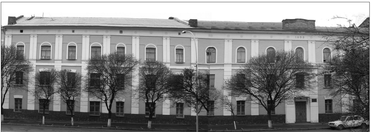
Рис. 2.2. Будівля юридичного факультету Державного аграрного коледжу управління і права, 1954 р., вул. Гагаріна, 3а. Світлина 2006 р.
