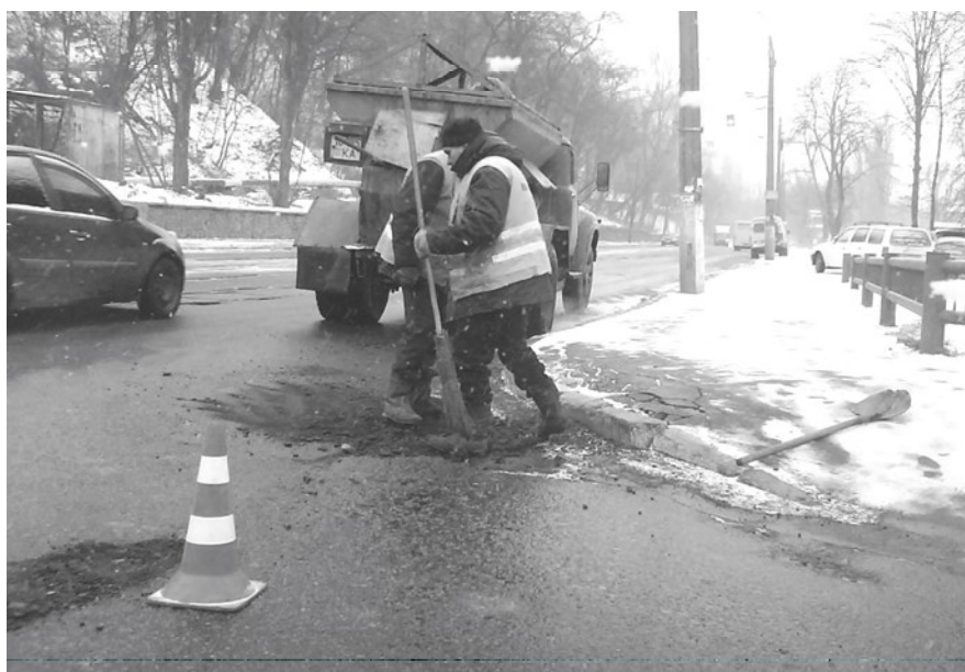
Рис. 2 Ямочный ремонт при низких температурах
