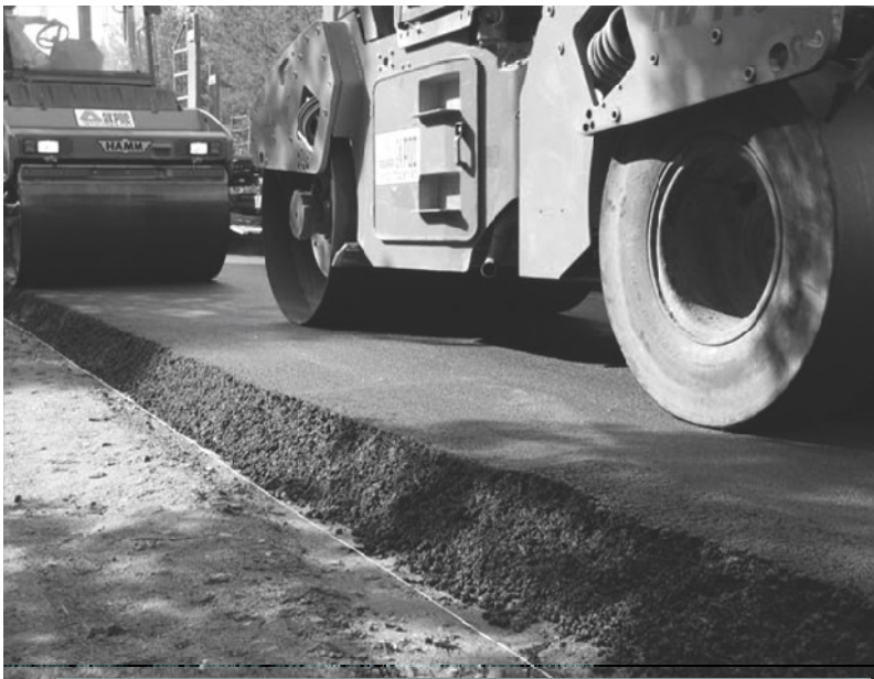
Рис. 3 Укладка первого слоя асфальта в Европе
