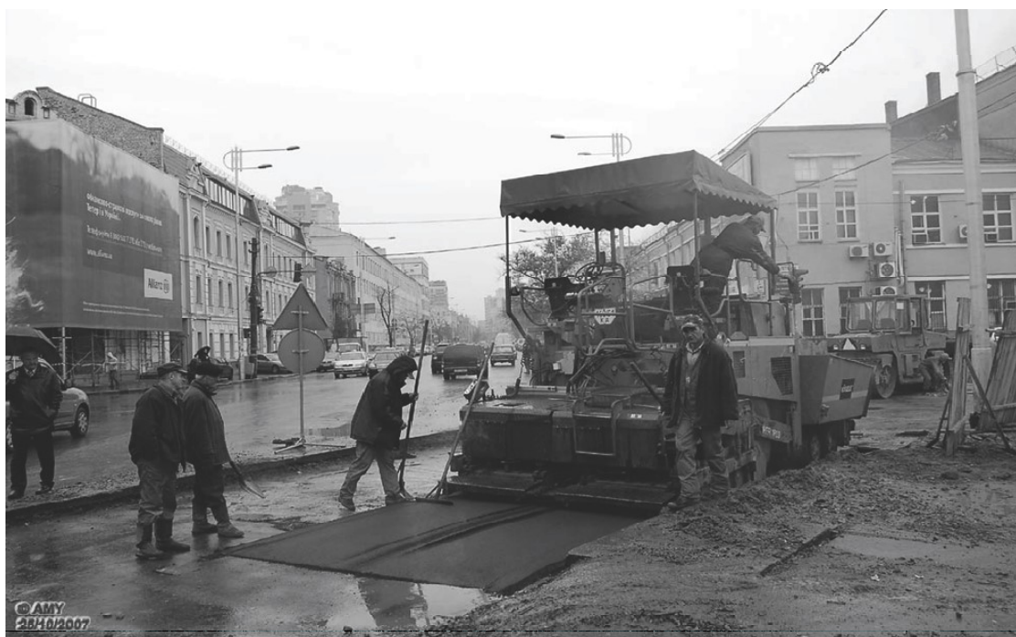
Рис. 1 Укладка асфальта в дождь
