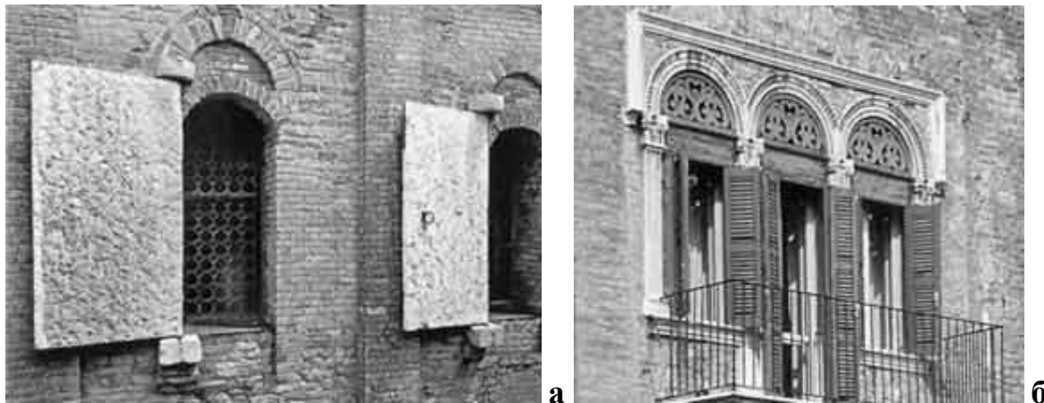
Рис.1. Кам'яні віконниці, Torcello, Італія (а). Віконниці-жалюзі захищають від сонця і регулюють вентиляцію, Монтана, Італія (б).
