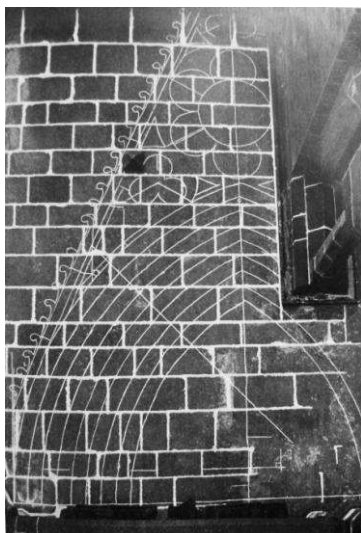
Рис. 10. Креслення на підлозі собору Notre-Dame in Clermon-Ferrand. Франція. XIII ст. (за D. Conrad)
