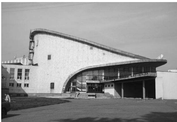
Рис. 6 Современное состояние Харьковского цирка. фото автора 2013г.
