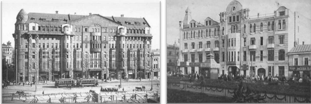
Рис.2. Застройка южного периметра бывшей Павловской площади: здание купеческого здания и гостиницы «Астория», 1910-1913 гг., арх.Н. В. Васильев, А. Н. Ржепишевский; доходный дом (крестьянский), 1913, арх. Б. Н. Корнеенко.
