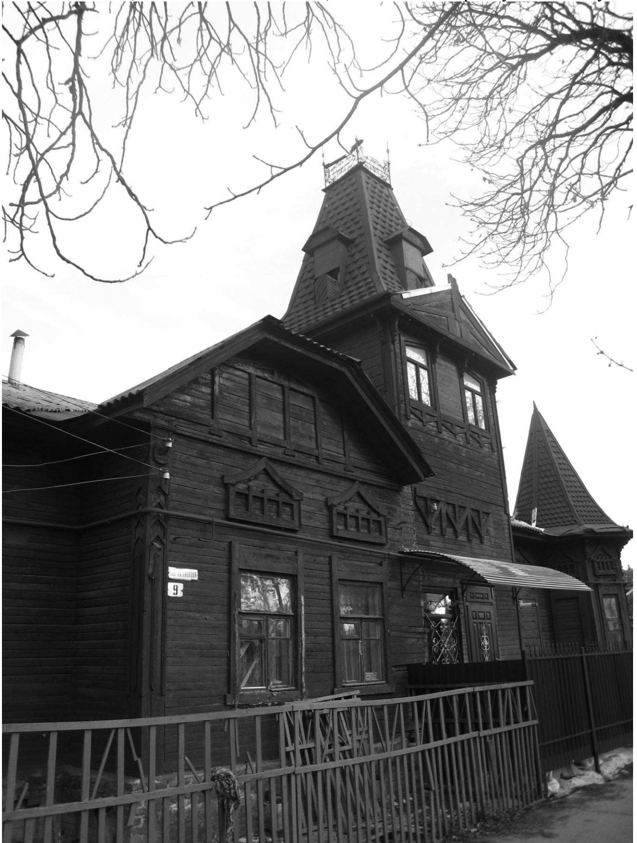
Рис.1. Будинок на вул. Павлова, 9. «Східна» орнаментика на фасаді.
