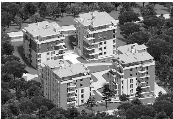
Рис. 5. ЖК «Оберіг», вул. Погулянка, 4а, 2012 р. [6].
