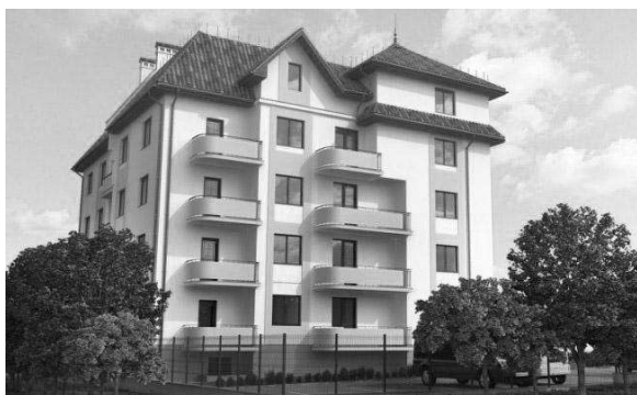
Рис. 19. ЖК «Чемпіон», вул. Колодзінського, 2015 р. [6].
