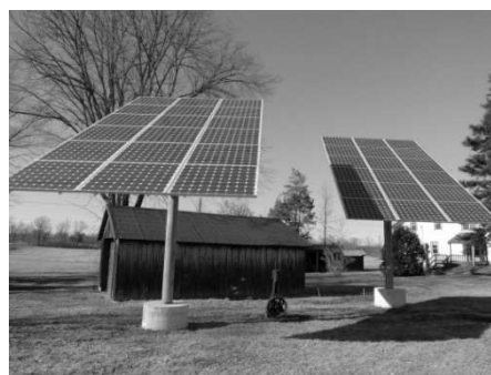
Рис. 9. Гелиоустановка на специальной подставке
