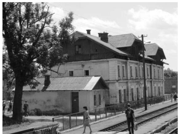
Рис.2. Вокз. Глібовичі (зруйн. 2015 р.)
