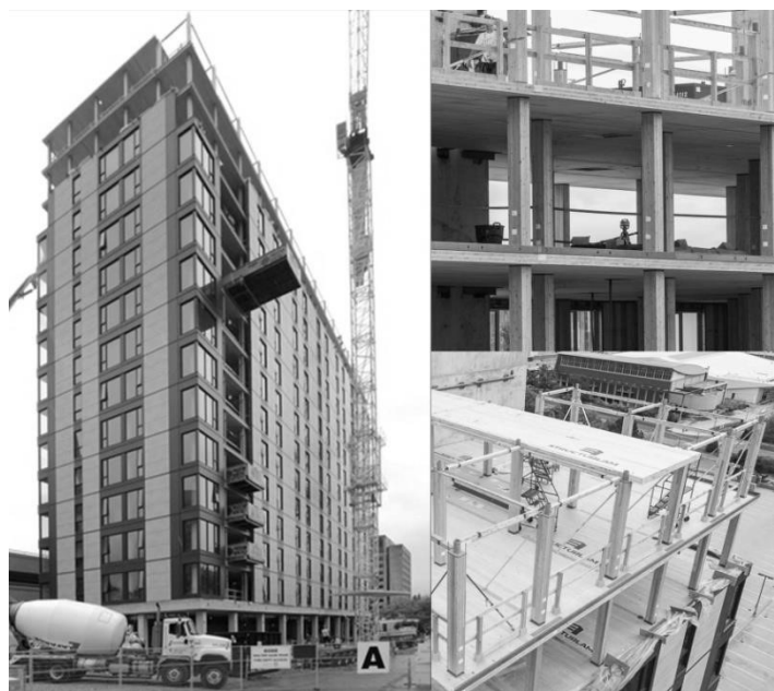
Рис. 4. Багатоповерховий будинок Brock Commons Phase (Британська Колумбія) [14]
