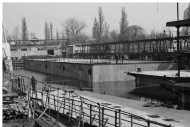
Рис. 1. Приклади застосування залізобетонних понтонів:
