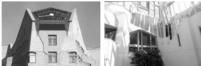
Рис. 3. Штаб квартира банку ING. 1993 р. Амстердам, Голландія. Арх. Антон Альбертс. Загальний вигляд комплексу. Фрагменти фасаду.
