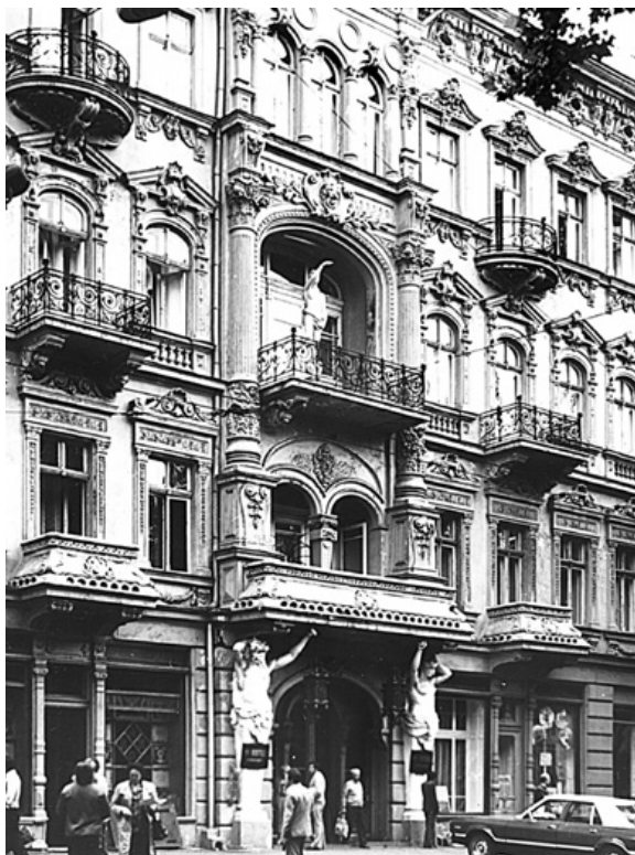
3. Готель «Брістоль» на вул. Пушкінська № 15, 1898–1899. Загальний вигляд
