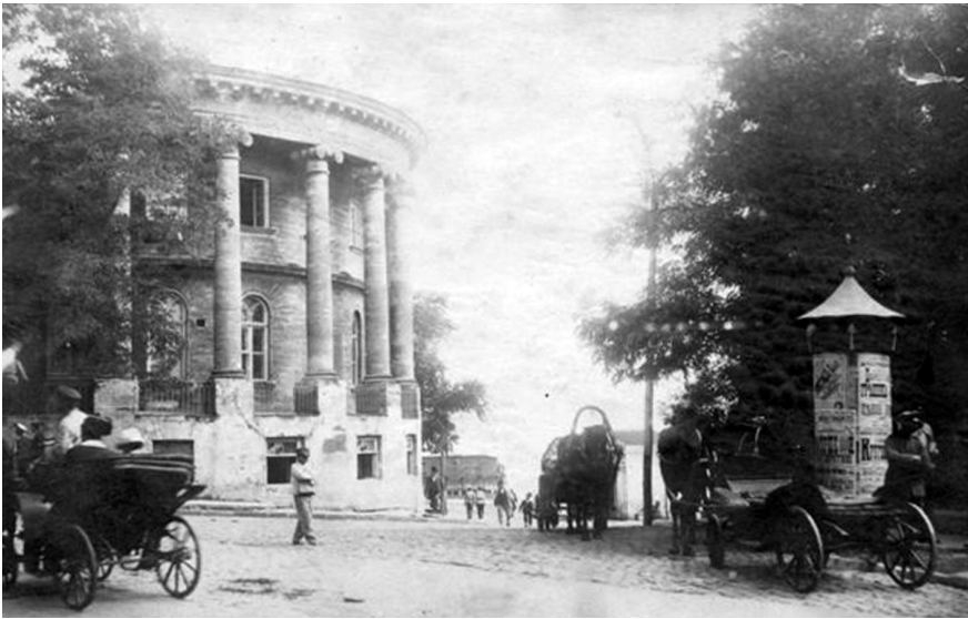
1. Керч, вул. Спіцинська. Будинок Домгера. Фотограф невідомий. Кінець XIX ст.
