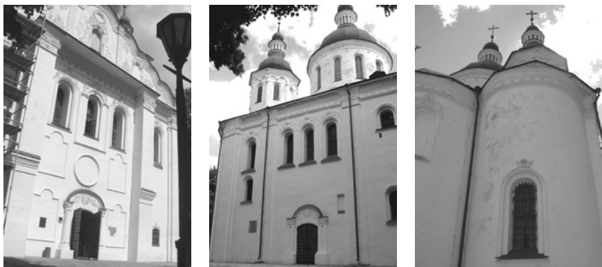
Кирилловская церковь в Киеве, современное состояние западного, северного и восточного фасадов
