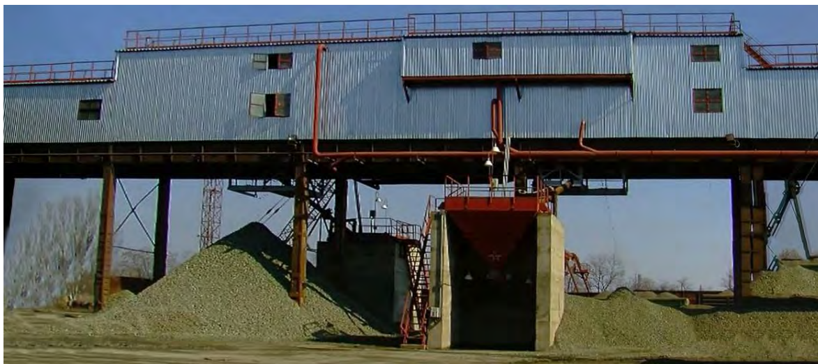
Рисунок 5 – Переработка шлаков силикомарганца на Никопольском заводе ферросплавов. МКС интегрирован в галерею дробильно-сортировочного комплекса. Украина, НЗФ
