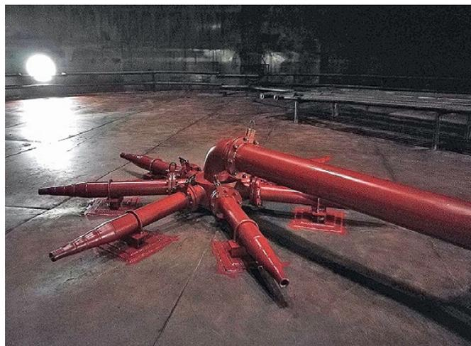
**Рис.2.** Система сопел струйно-эжекторного устройства
