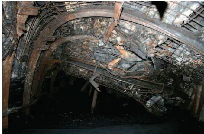
Рисунок 6 – Приклад вивалоутворення в підготовчій виробці
