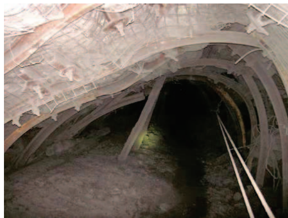
Рисунок 3 – Приклад деформації кріплення протяжної гірничої виробки внаслідок дії підвищеного несиметричного гірського тиску
