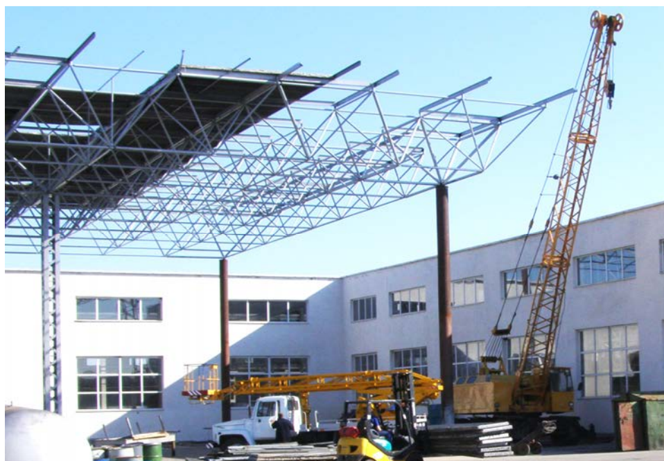
Рисунок 4 – Монтаж комбінованого покриття складських приміщень згідно з розробленими конструктивними рекомендаціями на підприємстві «Еко-Сфера», м. Калинівка.
