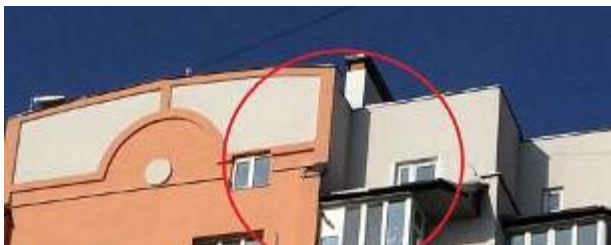
Рисунок 10 – Приклади самочинного переобладнання технічного поверху
