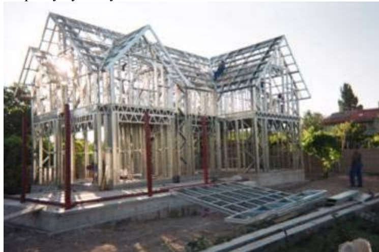
Рисунок 1 – Приклад каркасу будинку з ЛСТК
