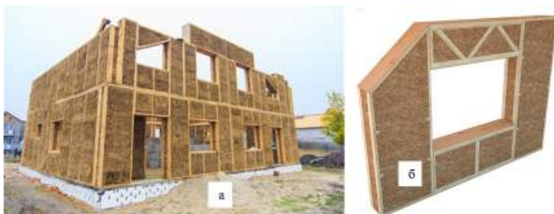
Рис. 11. Приклади зведення стін будинків за допомогою готових панелей з пресованої соломи (а) та приклад готової стінової панелі (б)
