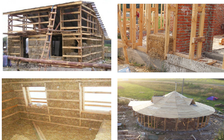
Рис. 10. Приклади зведення стін будинків з соломи за каркасною технологією (фото з мережі Інтернет)
