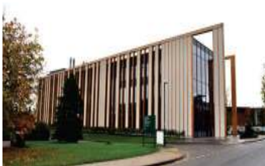
Рис. 6. Корпус Gateway Building університету Ноттингенма виконаний з солом'яних тюків
