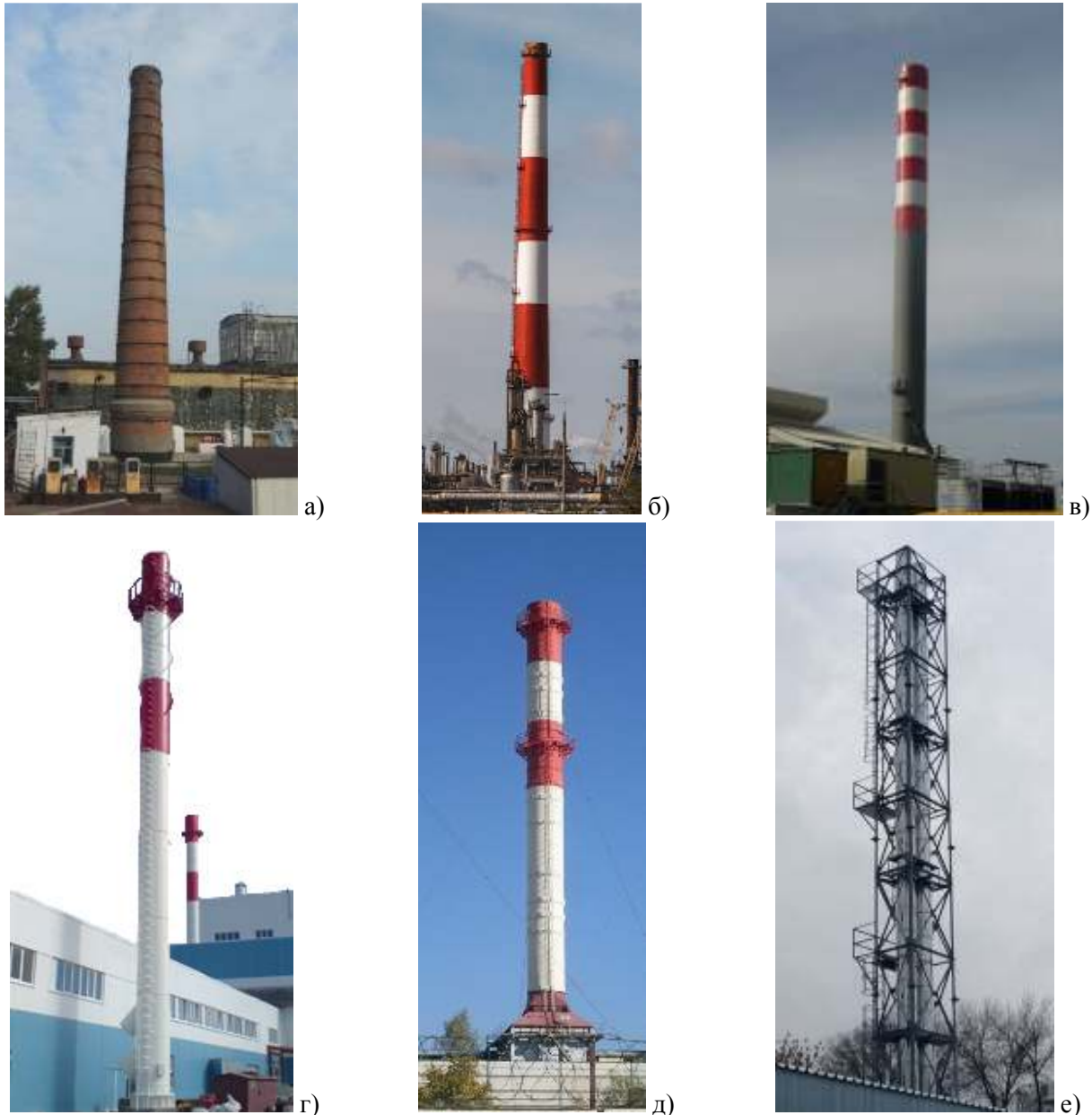
Рисунок 1 – Конструкції сучасних димових труб: а – цегляні;
