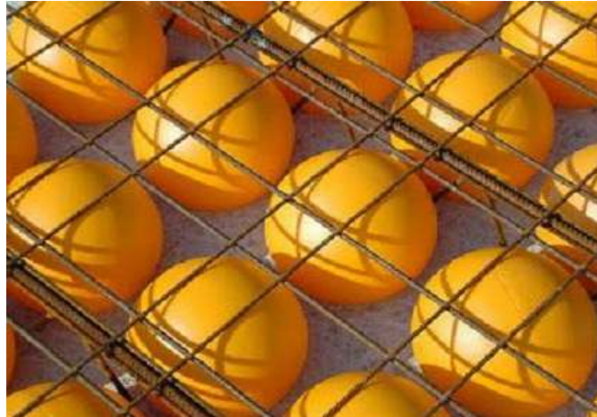
Рисунок 6 – Вкладиші-пустотоутворювачі за технологією Bubble Deck
