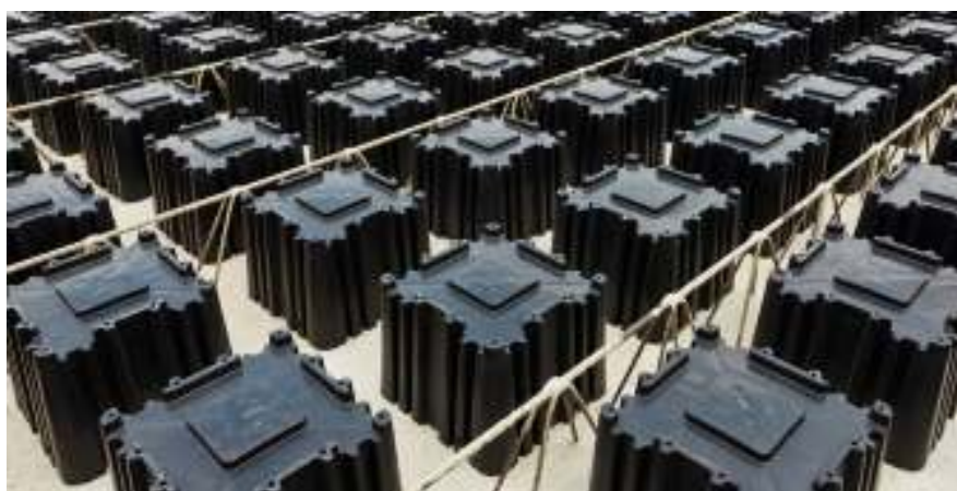
Рисунок 5 – Вкладиші-пустотоутворювачі за технологією Airdeck
