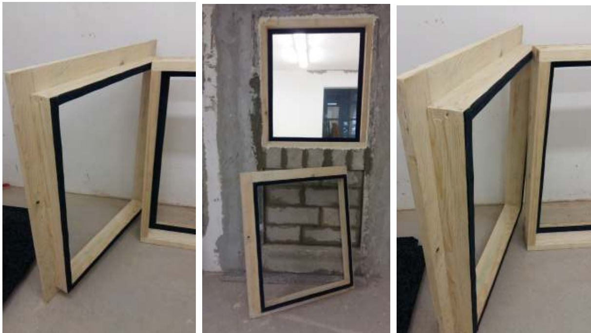
Рисунок 1, 2, 3 – Установка звукоізоляційних панелей під час проведення експерименту
