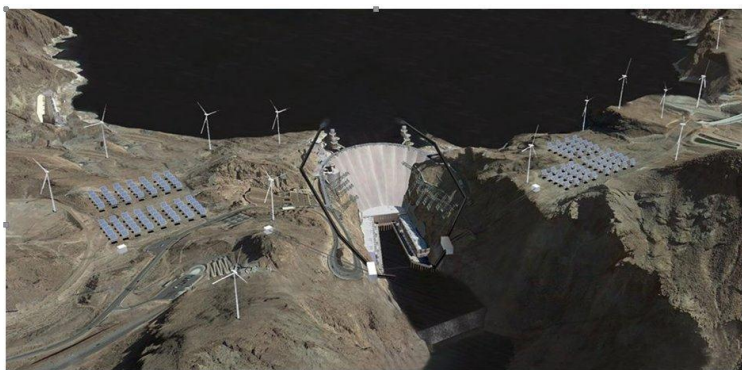
Рисунок 11 – Примерный вариант компоновки агрегатов и системы их управления для аккумуляции полученной ветровой и солнечной энергий
