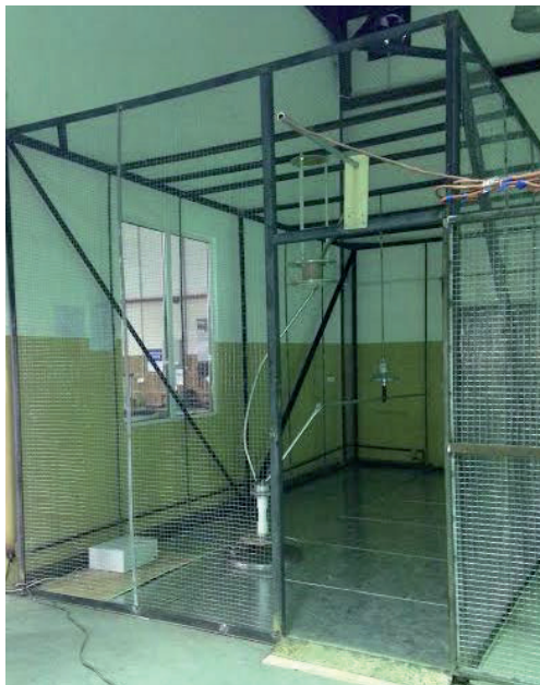
Рис. 3. Зовнішній вигляд установки для випробування високовольтних ізоляторів на допустимий рівень радіозавад (фото)
