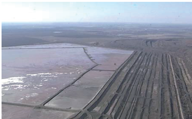
Рис. 2. Загальний вигляд хвостосховища ПАТ «Північний гірничо-збагачувальний комбінат»
