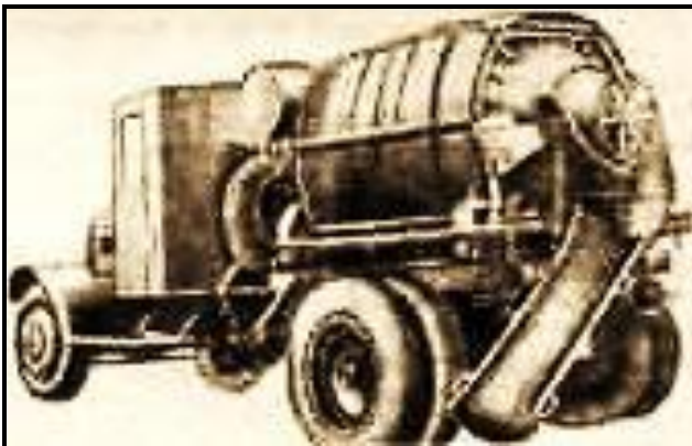
Рис.9. Перший серійний радянський автобетонозмішувач СССМ-738/С-49 на шасі ЯГ-6 (1938 р.)
