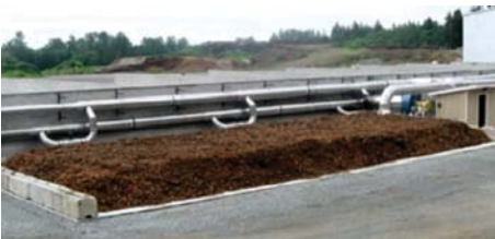
Рис. 12 – Біофільтр для очищення відпрацьованого повітря від неприємних запахів
