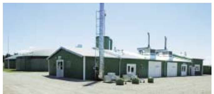
Рис. 2. Загальний вигляд біогазової установки
