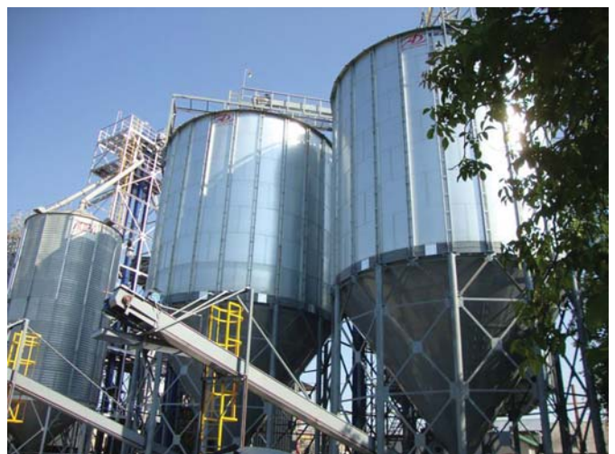
Рис. 1 – Зерносховища з конусним днищем
