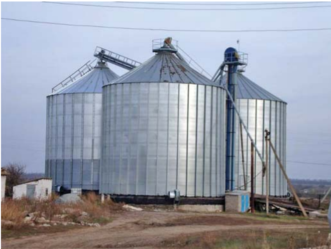
Рис. 2 – Зерносховища з плоским днищем
